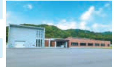
浄水場管理本館
