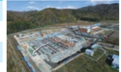
浄水場建設工事のようす
