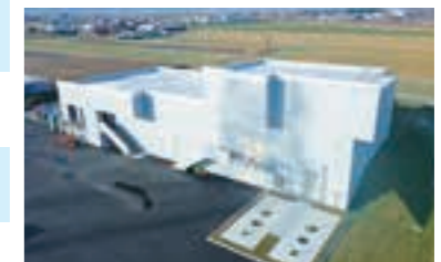
札幌ポンプ場・分水施設
