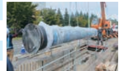
送水管理設工事のようす
